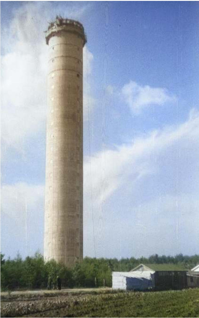
De top van het betonnen deel is bereikt. De 21e verdieping.
