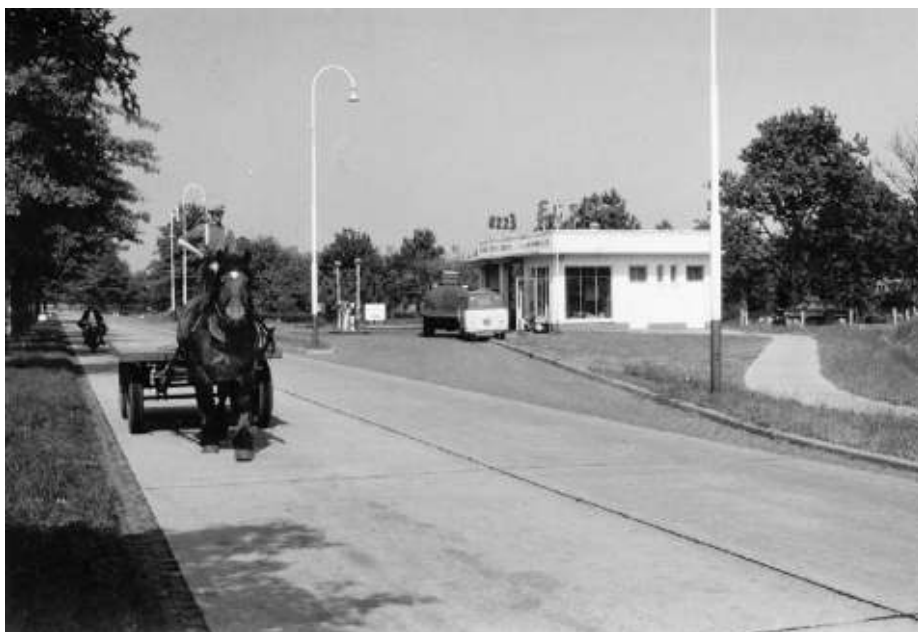
Kort voor de 2e Wereldoorlog werd een nieuwe provinciale weg aangelegd met een betonnen brug over het Eindhovens Kanaal, ter vervanging van de weg uit 1856.
