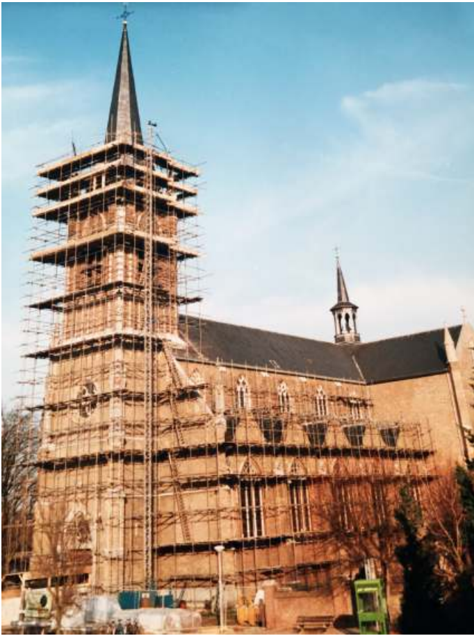
In de periode 1982-1985 had er een grote restauratie plaats van de H. Luciakerk.
