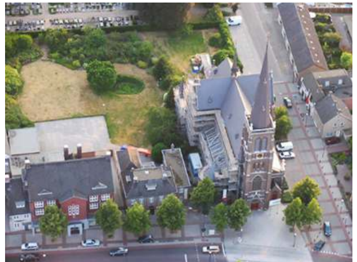
Op deze luchtfoto is mooi te zien hoe het bouwplan van de St. Lucia kerk gerealiseerd is.
