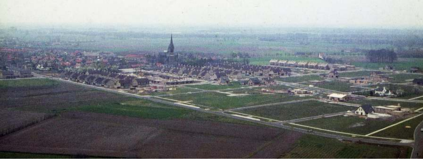
Kerkkackers I in aanbouw. Op de voorgrond Suijke.
