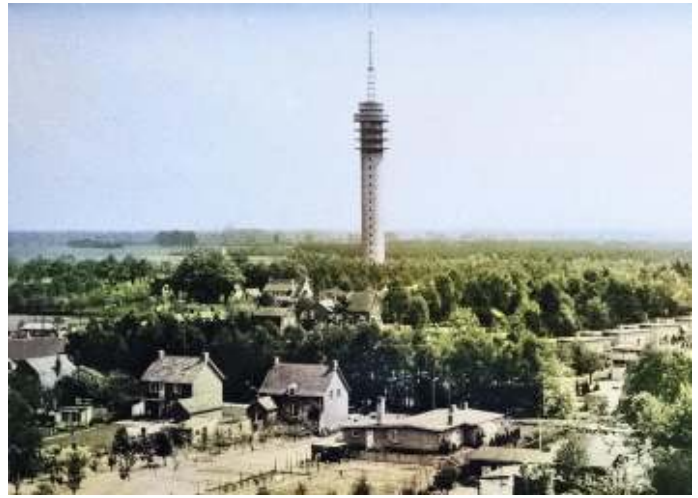
De toren van Mierlo (hier in 1964) werd gebruikt als relaisstation tussen Loon op Zand en Roermond. Daarnaast was de toren van Mierlo de eerste Nederlandse radiotoren.
