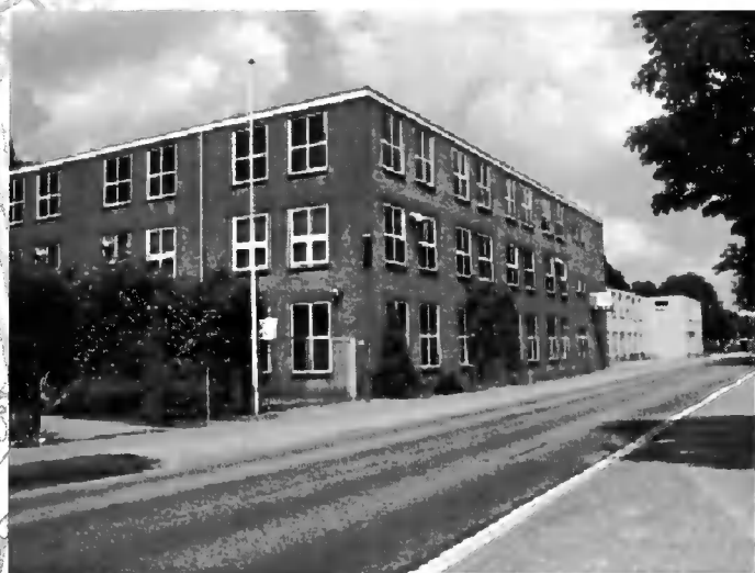
Afb. 34 De vierde nieuwbouw. Het pand gezien vanaf de Houtstraat, bij het naamsbord aan de gevel was later de personeels- en klanteningang. Weer later werd aan de buitenzijde een portaal aangebouwd.
