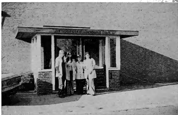
Afb. 214 De ingang aan de Houtsestraat voor personeel, leveranciers en expediteurs. Het portaal werd er later aangebouwd.
