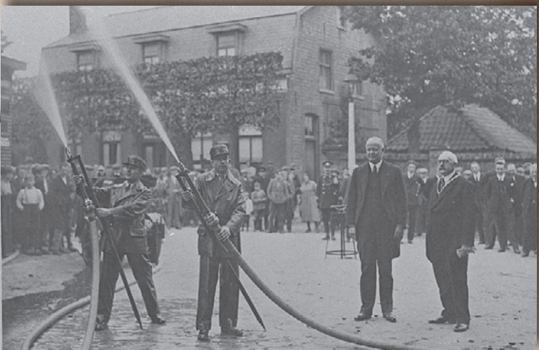
De opening van de waterleiding in 1932. Daarna werd het blussen van branden iets eenvoudiger.
