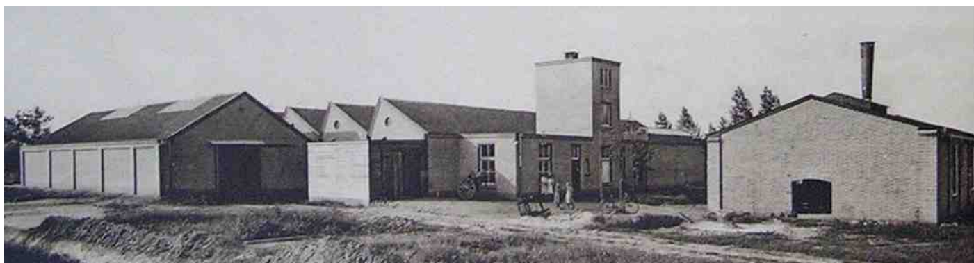
Het fabrieksgebouw van de firma Ign. de Haes aan de Tramweg.
